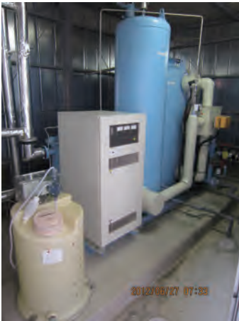
完オゾろ過機 (南箕輪養護老人ホーム処理能力6t)
