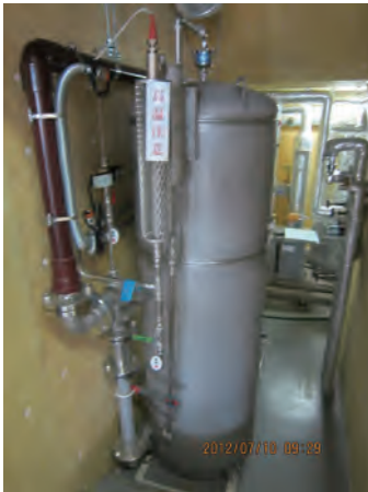
完オゾろ過機 (セラゾン・ミニ 処理能力12t)
